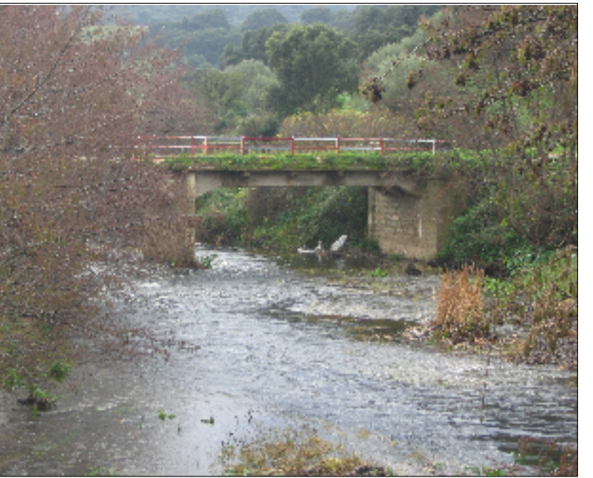
PONTE PAULAS DE JUNCU
