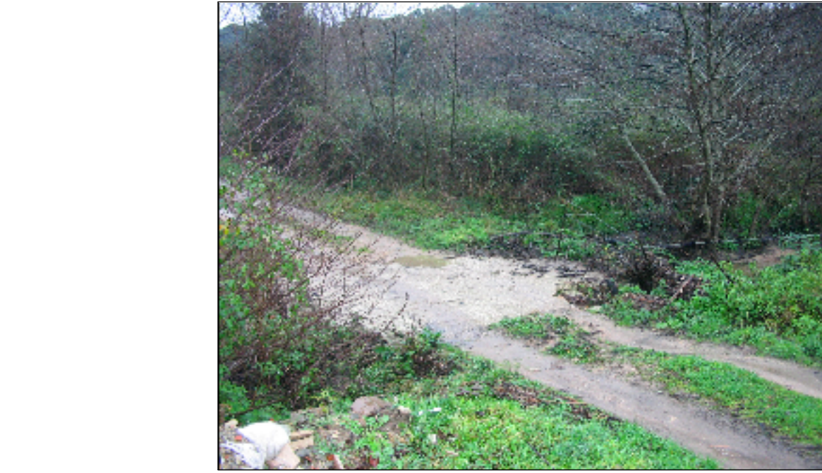
PONTE MURIGHETIS STRADA COMUNALE S.M. D'ARZACHENA
